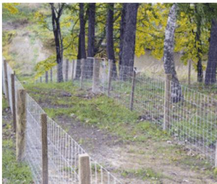
積雪地域でフィールドフェンスを張ったままにしておくと雪の重みでフェンスが下がり、杭が傾くなどして傷みます。
